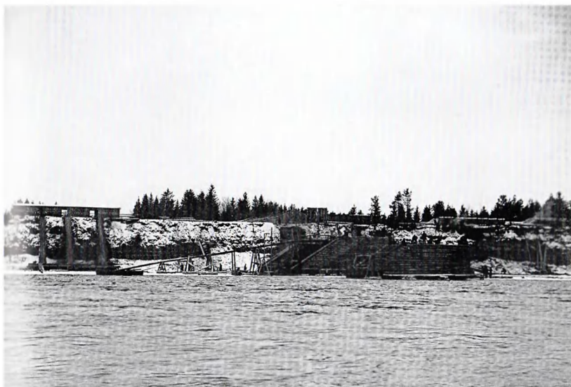
Установка опор у левого берега и загрузка их камнем
