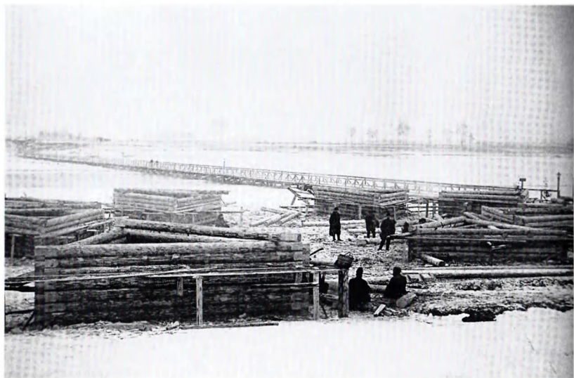
10. Общий вид моста на козлах и якорных ряжей для наплавного моста
