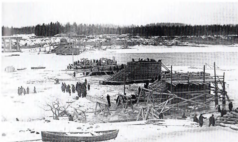
1 - Сборка и установка опор моста
